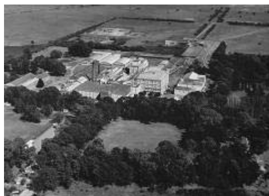
Figura 2 - Edificio y predio del ex frigorífico Fuente: NORDHEIMER S.R.L. Disponible en: < www.nordheimer.com >
